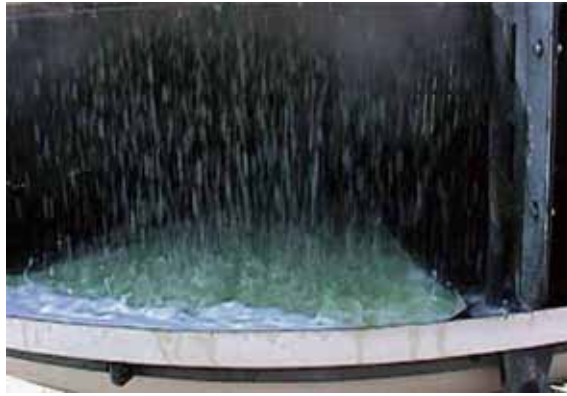
写真 - 6 過酸化水素による化学洗浄 冷却水系に過酸化水素を添加し化学洗浄している状況。過酸化水素とスライムの反応により発泡しています。同時に殺菌も行われています。
