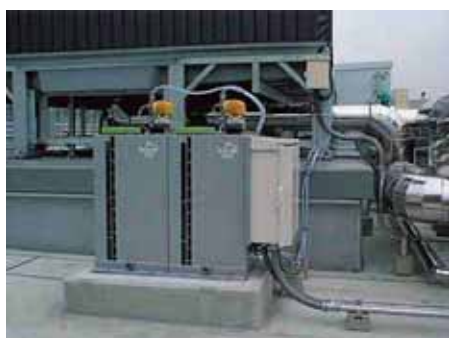
写真 - 4 薬剤注入、自動ブロー装置
