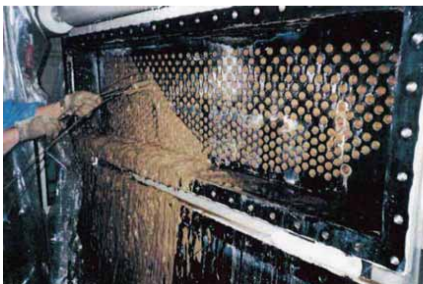
写真 - 5 スライムの物理清掃
